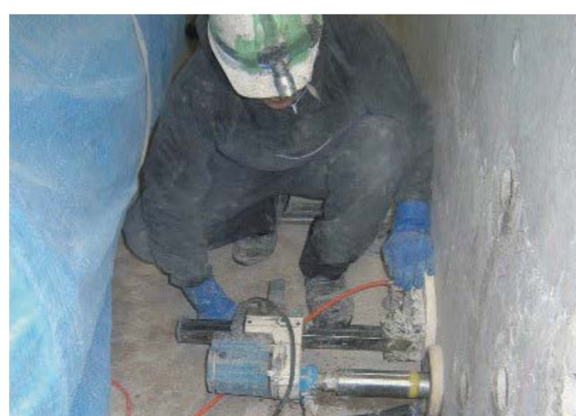
狭隘箇所での施工(水処理施設)
