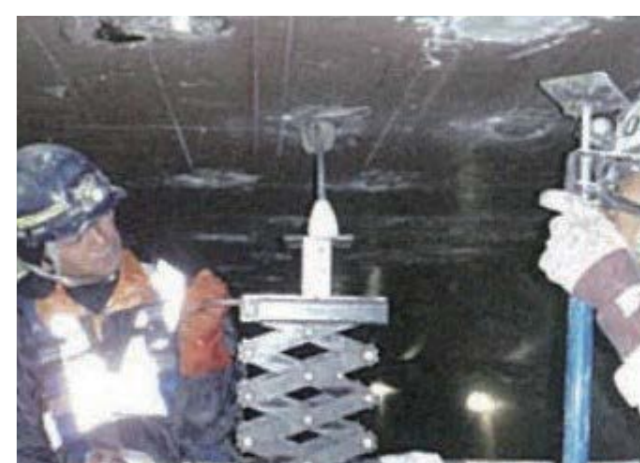
上向き施工(放水路)
