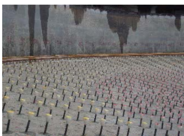
重力濃縮槽の底版の補強
