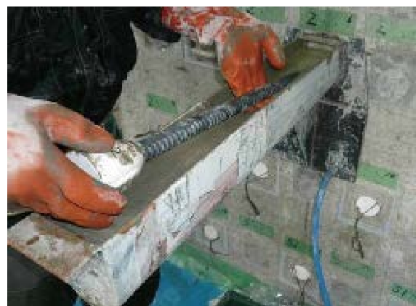
セラミックキャップバー(CCb)の挿入状況
