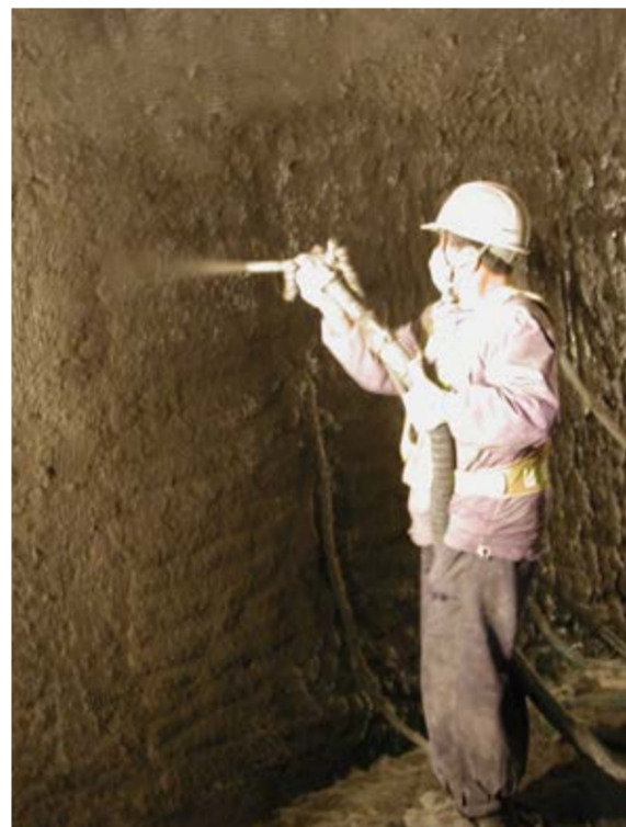
吹付け用「ECCショット」による補修例
