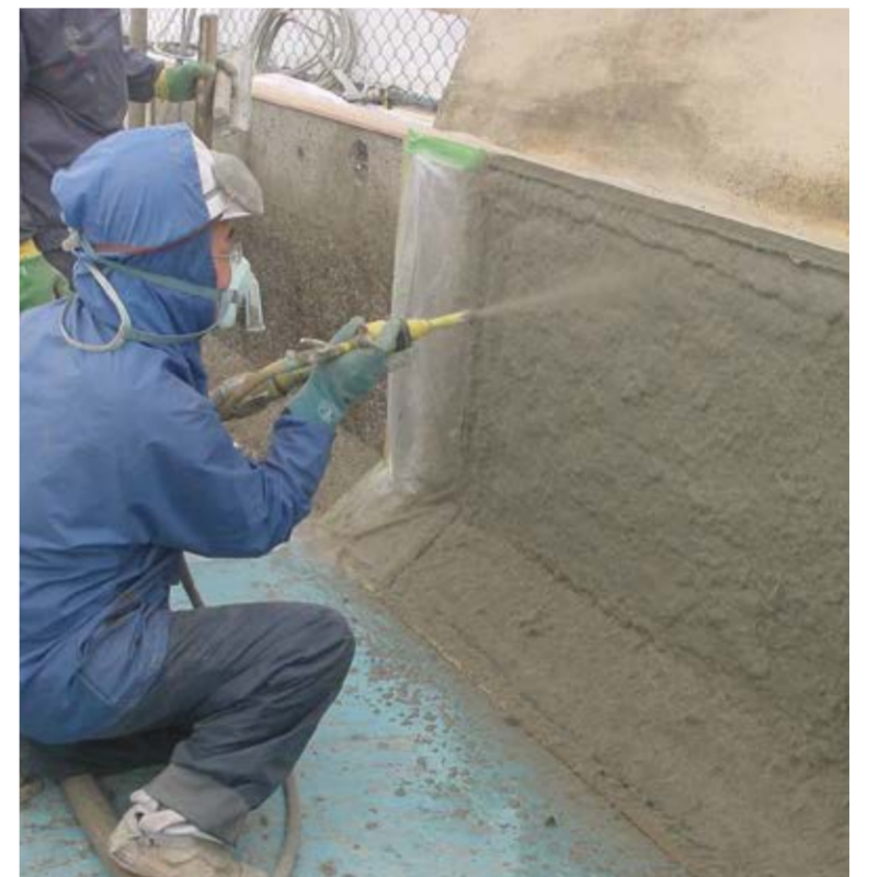
吹付け用「ECCショット」による補修例
