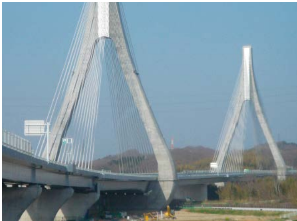
コンクリート構造物の例
