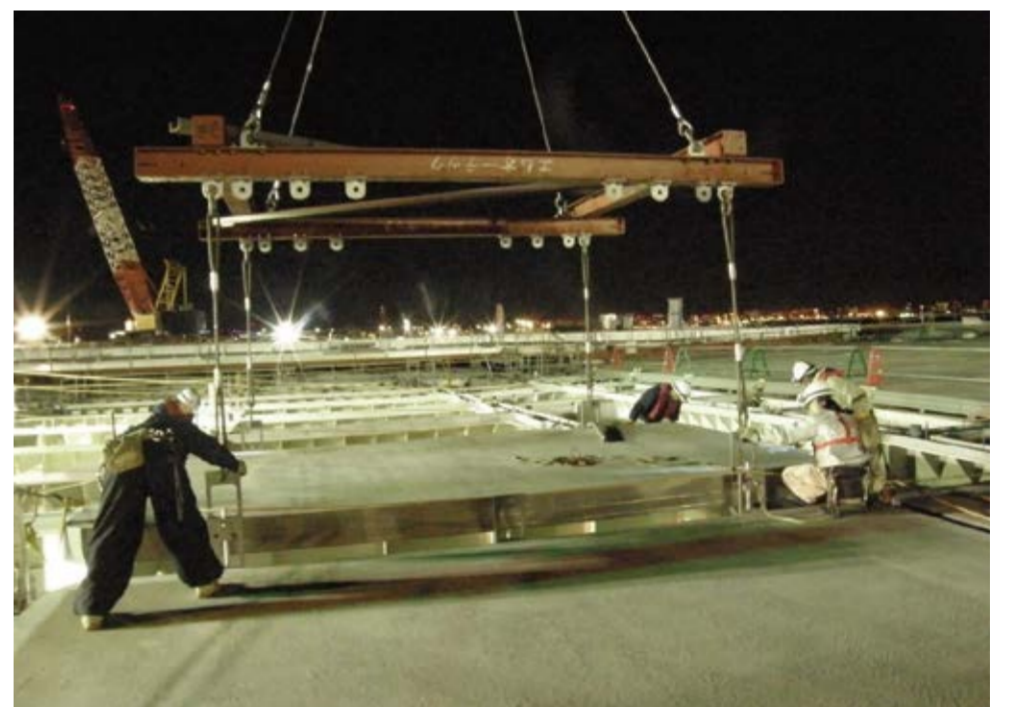
サクセム床版の架設
