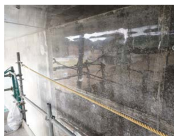
シート撤去直後の外観
