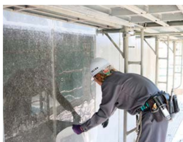
シート撤去作業状況
