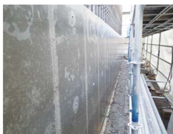
シートによる養生状況
