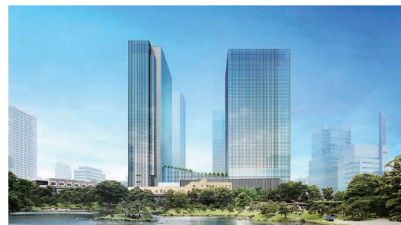
A街区竣工(奥/左:南館 中央:ターミナル 右:本館 手前/東京モノレール浜松町駅) ※本ページのCGはすべてイメージです
