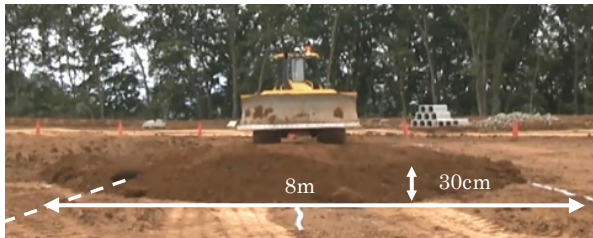
Fig.7 造成工事での自動まき出し結果の例 (Result of Automatic Spreading in Earth Work)
