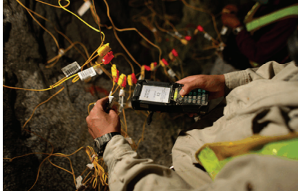
Photo 1 切羽における秒時差設定状況 (Delay Time Setting with Scanner)
