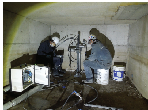
Photo 9 ピット内作業 (Work in Basement Pit)
