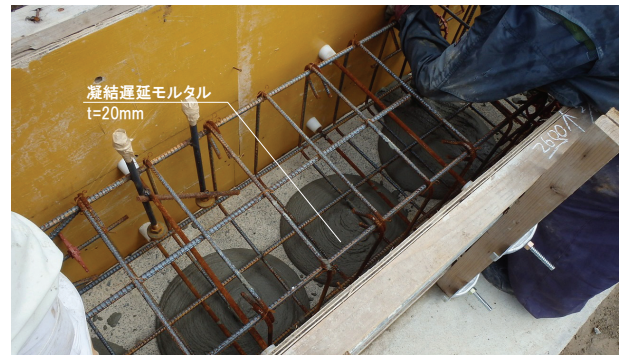
Photo 3 モルタルの打込み状況 (Placing of Mortar)
