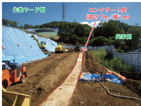
コンクリート地中遮振壁の設置状況
