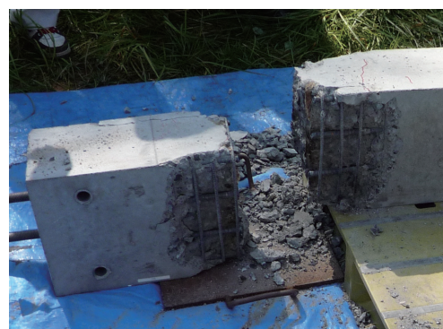
切断解体状況
