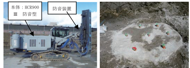
Photo 2 ロックドリルによる穿孔作業 (Boring By Rock Drill)
