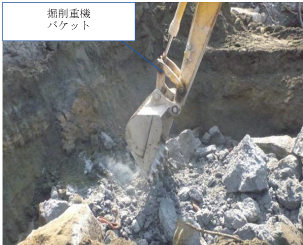
Photo 10 No. ②の2次破碎状況 (No. ② Test Result)
