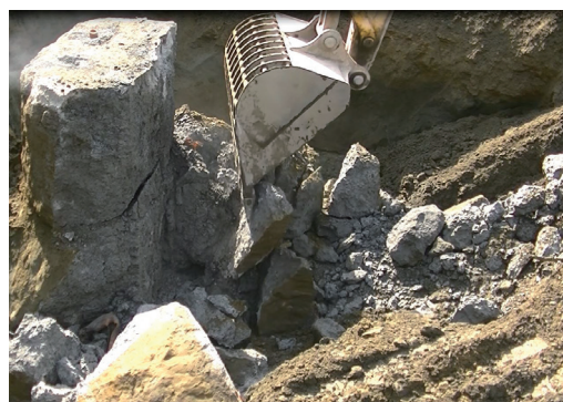
発破後 掘削及びガラの除去状況 Excavation and Removal of Broken Pieces
