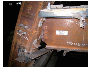
Photo 2 梁および柱の破壊状況 5) (Fracture of Beam and Column)
