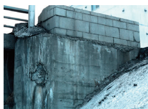
Photo 1 凍害によるコンクリート構造物の劣化例 (A degradation Example of a Concrete Structure by Freezing Damage)
