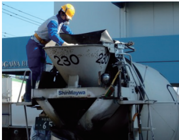
Photo 6 ミキサへの中空微小球の投入状況
