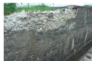
Photo 1 凍害によるコンクリート構造物の劣化例 (A degradation Example of a Concrete Structure by Freezing Damage)
