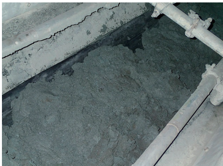
Photo 11 現場での排土状況
