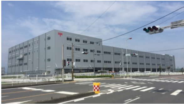
Photo 1 事務所棟の建物外観 (Office Building)
