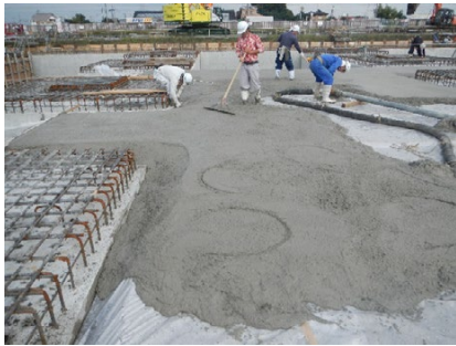
Photo 2 レベルコン打設状況 (Placing of Leveling Concrete)
