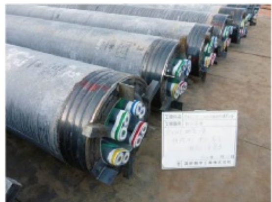
Photo 1 PHC 杭利用地中熱交換器プレセット工法 (Preset Construction Method for Geothermal Heat Exchanger with PHC Piles)
