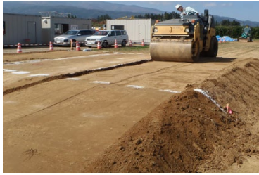
Photo 3 盛土状況 (Status of Fill Work)
