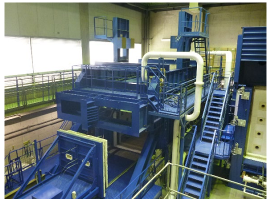
Photo 2 耐火試験炉 (技術研究所) (Fire Resistant Furnace)
