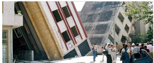
Photo 3 転倒モーメントにより傾いた幅が狭い建物
