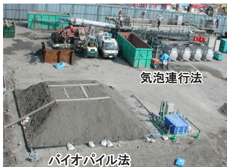
油含有土の気泡連行法と バイオパイル法の場内連続処理
