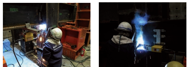
(a) 上向溶接 (b) 立向溶接
