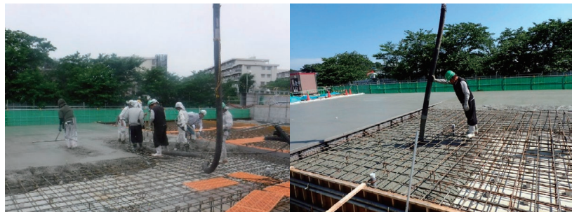
スランプ8cmの普通コンクリート 計8名 安価な締固め不要コンクリート 計1名
