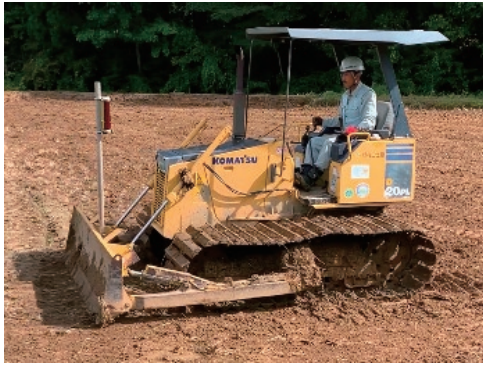
Photo 6 ICTブルドーザ (ICT Bulldozer)
