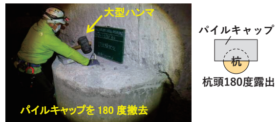
Photo 2 解体中の IT 試験（11Y 杭） (Integrity Test under Demolition State)
