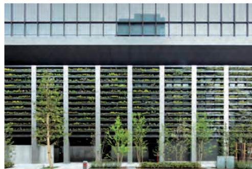
旧芝離宮恩賜庭園を望む浜松町駅に隣接する、世界貿易センタービルディングの建替えプロジェクトの一部。旧WTCビルの歴史を発展的に継承し、賃貸オフィス及びサービス店舗で構成される、高さ約200mの超高層ビルである。限定された敷地の中で最大限の事業性を確保するため、庭園側のファサードをスレンダーなプロポーションとし、浜松町の新たなランドマークとして建設された。高い塔状比を実現するため、建物の構造は地中連続壁躯体を採用し、HiDAX-Rとともに、高い居住性を確保した。また、高性能ガラスやDHC(地域冷暖房)などの採用により環境負荷を低減し、帰宅困難者の滞留スペースの確保、駅と連結するバリアフリールートの新設することで、利用者に対して安全で快適な交通動線を提供し、建物価値を高めている。
