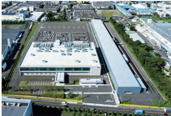
自動車用ランプを主体に展開するメーカーの研究施設。既存工場の対面に設技棟とライトトンネル(LT)棟と呼ばれる試験施設を新設した。設技棟でアイデアを生み出しLT棟で実証試験を行い、既存工場で製品化する「ものづくりのサイクル」を確立し、新たな価値を創造する拠点の再構築を図った。新設2棟に加え、屋外試験エリアを複数配置して、4haの敷地を最大限活用した。設技棟1階には中央アトリウムを起点に実験室を配置し、2階は間仕切りのない開放的なワークプレイスがものづくりの一体感を醸成すると共に、集中エリア・交流エリアが研究者の多様な働き方を支援する。LT棟は全長220mの世界最長クラスの屋内試験施設で、雨・霧・昼夜を再現できる設備を備え、4車線の舗装道路を整備している。
