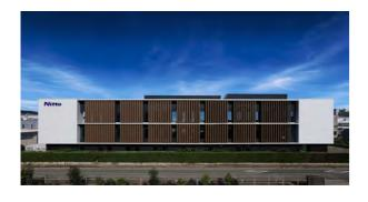
日東電工豊橋事業所操業60周年に合わせ、豊橋事業所の司令塔の役割を担うESG推進のフラッグシップオフィスとして計画。また、オフィスワーカーの快適性の最大化を図りながら、カーボンニュートラル化への挑戦としてゼロエネルギービルを実現し、環境性能と快適性を兼ね備えたオフィスを創出した(BELS:Net ZEB認証+CASBEEスマートウェルネスオフィスSランク認証)。日射負荷を抑制する再生木ルーバーの原材料には、事業所から排出される廃プラスチックを用いて環境負荷低減を図っている。オフィスの中心に配置したアトリウムには、カフェ、ライブラリー、多様な打合せスペースを設け、事業所で働くすべてのワーカーが立ち寄りやすい空間づくりを行った。
