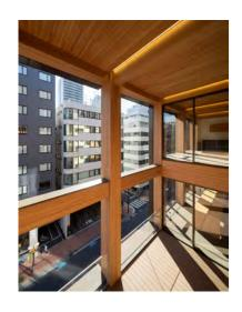
関東大震災直後、復興建築資材としてベニヤ板供給のため起業したジューテック(ジオリーブグループ)を創業の地に本社機能を還すプロジェクトである。回型の敷地形状を活かし、地震水平力・経年変位・耐火性能など木質構造の課題解決に向けて3つのブロックで構成した。西側に「執務ゾーン(鉄骨造)」、「緩衝ゾーン」を挟み、東側・新橋赤レンガ通りに面して多様な活動を促す「コミュニケーションハブ」は、開放的な階段でフロアを結び部門間の交流を活性化すると共に、高透過ガラス越しに木架構を表出し、街に開き企業活動や理念を広く発信する。新橋発祥の老舗企業の願いである良質な街並形成に応えた。
