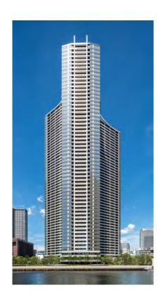
地下連絡通路や人道橋等インフラー体の大規模再開発事業「GRAND MARINA TOKYO」の南側、二方を水辺に面して誕生した高さ約195m、58階1,665戸の超高層集合住宅。建物形状をトライスター型として、周囲からの引きの空間を確保しボリュームを凝縮。敷地内に豊かな広場を創出し、都心にありながら水と緑に囲まれた施設として計画した。外観は統一された色調のなかでウイング毎に分節化し、ボリューム感をコントロールしつつ凛とした佇まいを目指した。幅広いライフスタイルに対応する多彩な住戸ブラン、躯体を的確に制御する制震構造「VDコアフレーム構法」、環境負荷の軽減といった作り込みを行っている。災害時には共用部を屋内避難スペースとして利用するなど地域防災にも貢献する計画。
