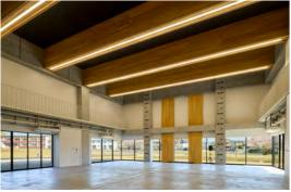
大学に新設される工学部の活動拠点の建設と、新たな顔となるキャンパス北側の外構を整備するプロジェクト。 学園の"建学の精神+共創"をキーワードとし、活動の可視化・交流の誘発・フレキシビリティを確保、環境共生型の建築・外構をコンセプトとした。人の気配や研究活動の様子が相互に伝わり交流を促進する平面・断面計画とした。外皮はエキスパンドメタルを使用し、方位毎に日射遮蔽効果を考慮した外観デザインとし、ZEB-Ready認証・CASBEE柏Sランクを取得。大型実験室と大教室にはCLT耐震壁とRC梁・CLT型枠のハイブリット構法「RCLT梁」を採用。駅方面からの学生・来客を迎えるため地形風土を踏まえた外構計画とし、バイオスウェルやレインガーデンにより環境共生型キャンパスの実現を目指した。
