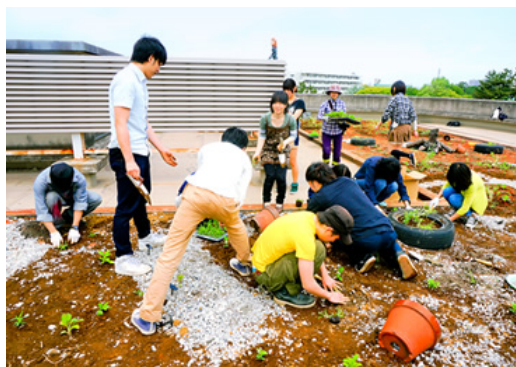
参加者が自ら施工 (千葉市)
