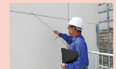
技術者による建物劣化診断
